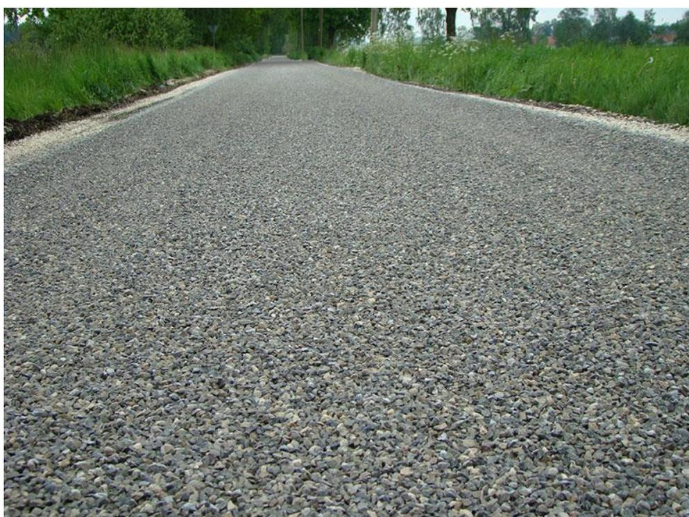
Die sogenannte Tränkdecke bietet sich vor allem bei Streckenführungen an, die besonders gefährdet durch Erosion bzw. abfließendes Oberflächenwasser sind. Im Vergleich zu geschotterten Wegen fällt kein bzw. kaum Unterhalt an.
